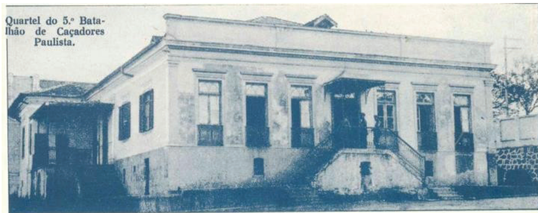
Figura 10 Fachada do 5º Batalhão da Força Pública
